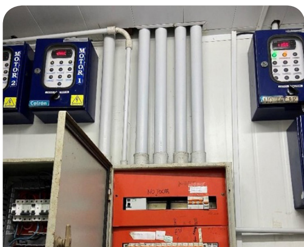
Figura 69. Sellado inadecuado de pase para cables.
