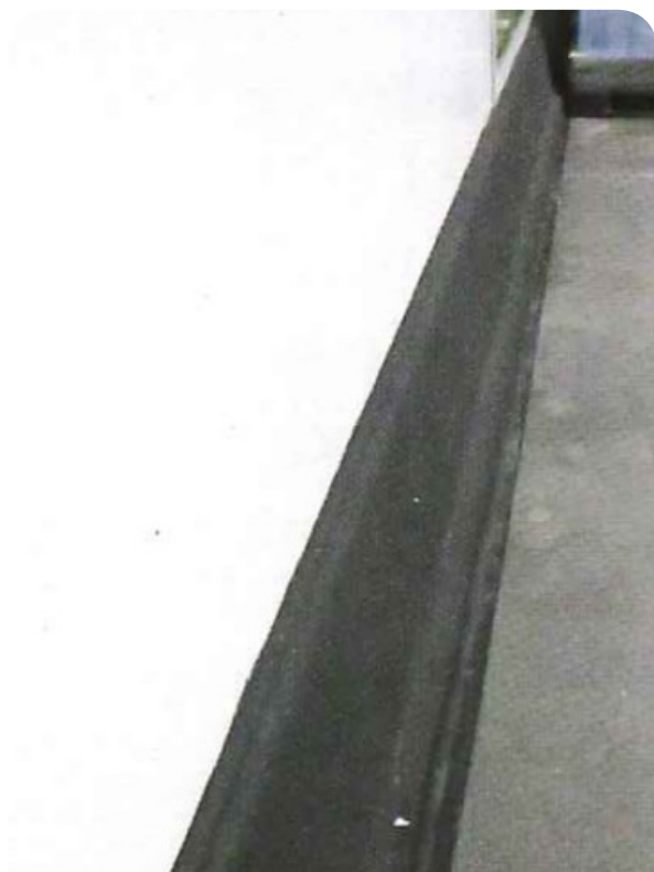
Figura 57. Protección de encuentro entre panel y hormigón.
