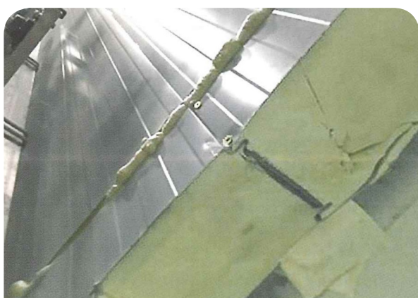
Figura 67. Alma a la vista y sellado deficiente.
