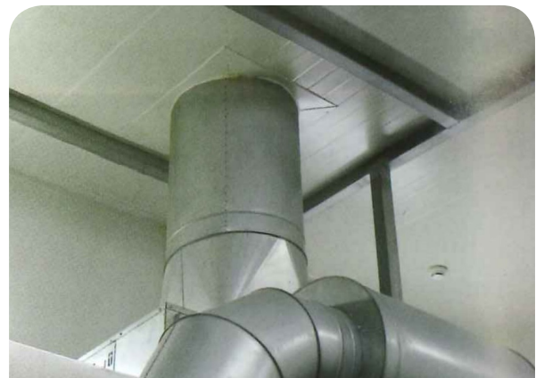
Figura 54. Paso de conductos a través de paneles.
