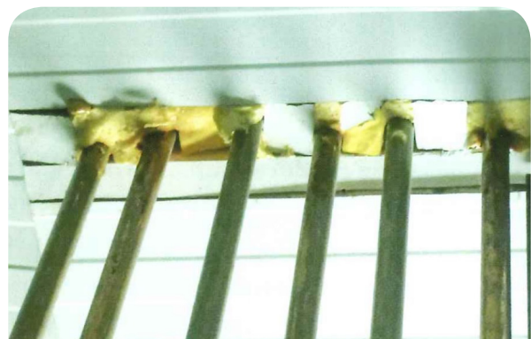
Figura 64. Penetración en un panel sándwich para paso de conductos, sellado inadecuadamente con espuma de poliuretano.
