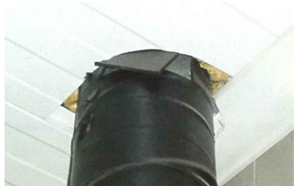
Figura 62. Sellado de penetración en panel sándwich ejecutado a base de espuma de poliuretano y planchas de poliestireno.
