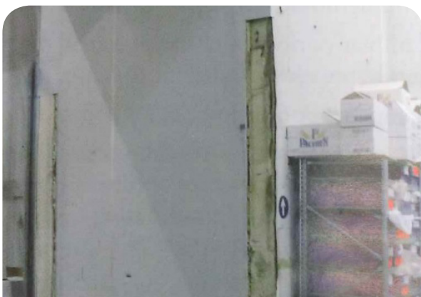
Figura 63. Panel sándwich que ha sido golpeado, quedando su relleno expuesto.
