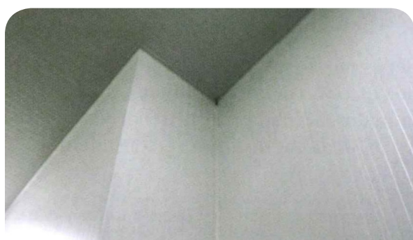
Figura 59. Sellado de encuentro entre paneles.
