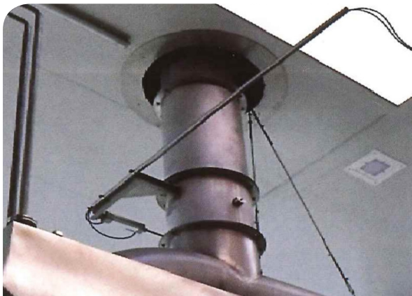
Figura 53. Paso de conductos a través de paneles con collarín.
