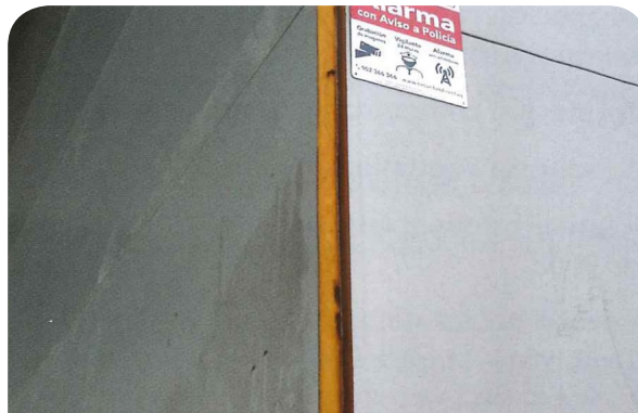
Figura 66. Cerramiento ejecutado a base de paneles sándwich, cuyo encuentro en la esquina no se ha ejecutado adecuadamente.
